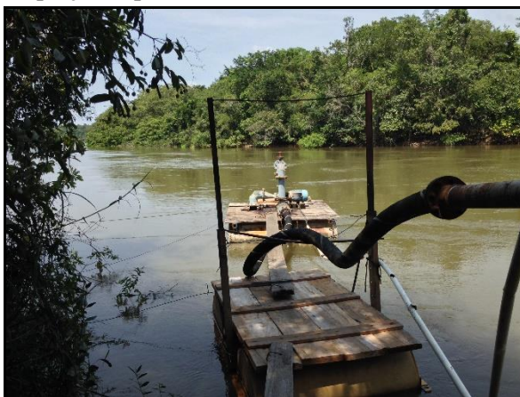
Figura 2. Captação superficial no rio Arinos, Porto dos Gaúchos-MT
