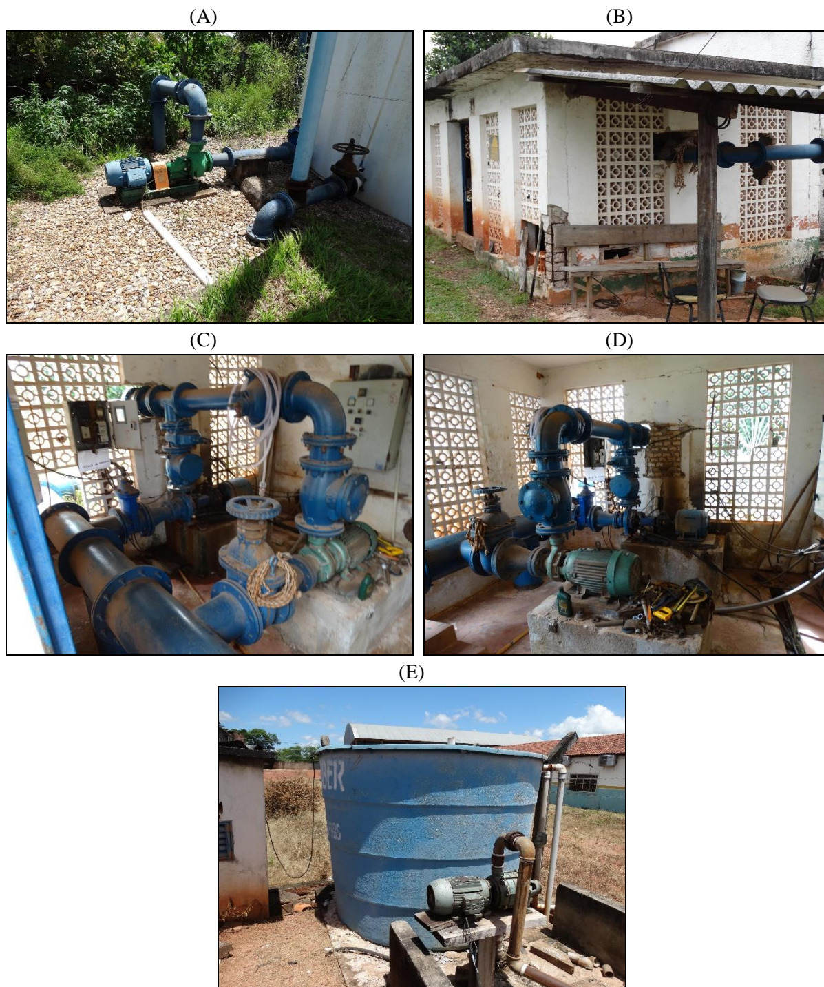
Figura 4. (A) Estação elevatória 01 (B) Estrutura de alvenaria que abriga a EEAT-02 e a EEAT-03 (C) Visão geral da EEAT-02 (D) EEAT-03 instalada na estrutura de alvenaria (E) Estação elevatória 04 da Guarda Mirim
