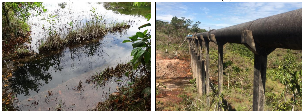
Figura 2. (A) Área de captação da mina Moreninha (B) Adutora de água bruta de cimento amianto (A) (B)
