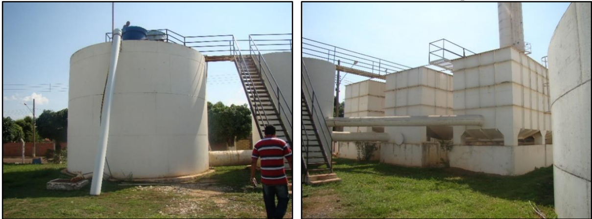
Figura 3. ETA existente em na sede do DAE de Nova Olímpia
