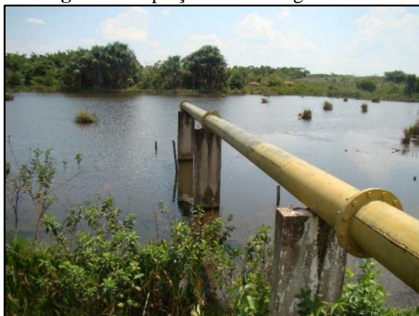
Figura 2. Captações do Córrego Mineiro
