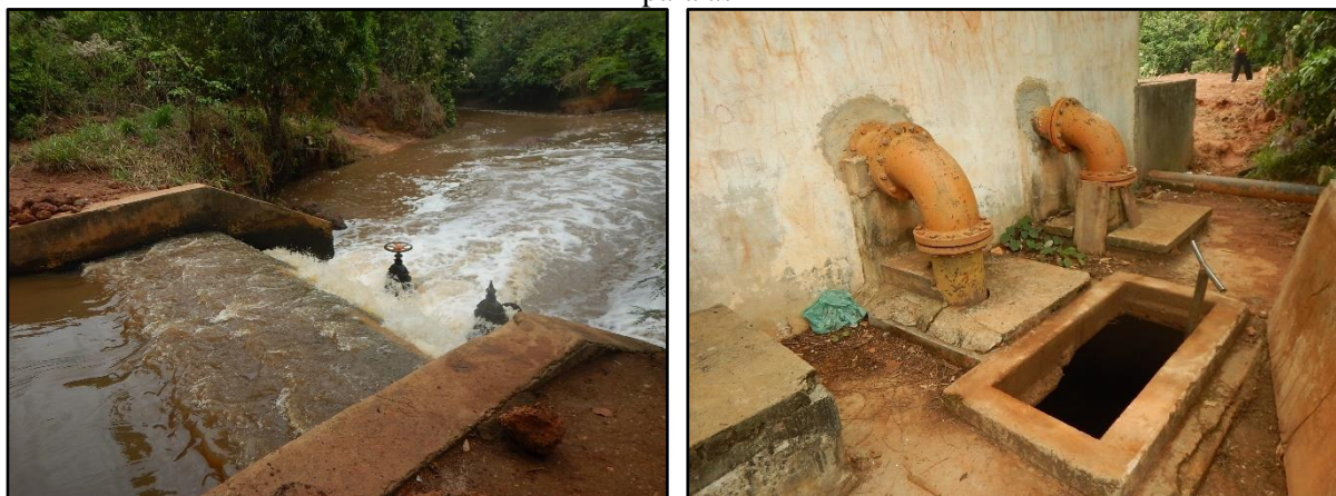
Figura 2. Captação de água em Juína – tomada indireta com elevação de nível e poço de sucção da EEAB para as ETA
