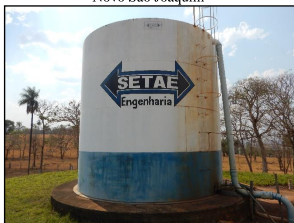
Figura 2. Reservatório de 200 m 3 de água de Novo São Joaquim
