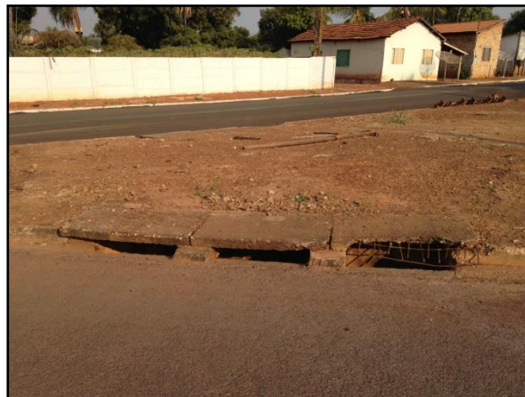
Figura 5. Boca de lobo tripla com a estrutura comprometida, situada na rua Joaquim R. de Souza
