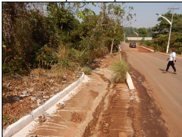
Figura 4. Vista parcial do sistema de microdrenagem na MT-110 em Novo São Joaquim, saída rápida
