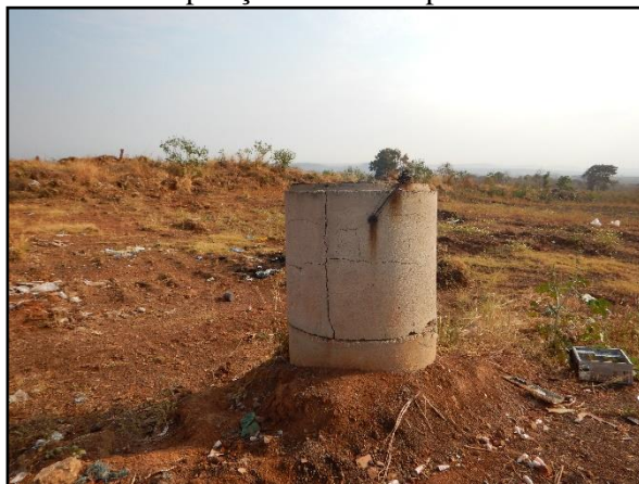
Figura 10. Vista da manilha utilizada para disposição dos RSS tipo E
