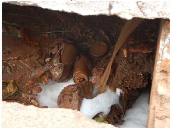
Figura 7. Ligação clandestina de esgoto ao sistema de drenagem da rua Manoel Brito
