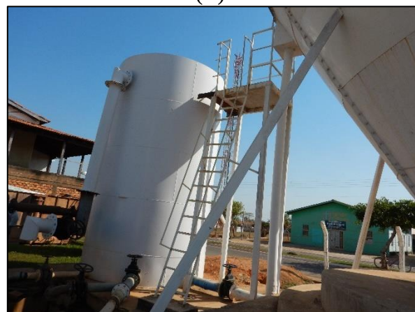
Figura 3. (A) Visão geral da ETA (B) Filtro russo (A) (B)
