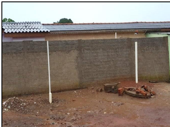
Figura 8. Fossas absorventes instaladas no passeio público na Rua dos Limoeiros, no bairro São Francisco
