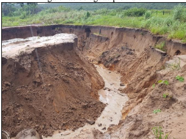
Figura 12. Erosões formadas nos deságües das galerias de águas pluviais
