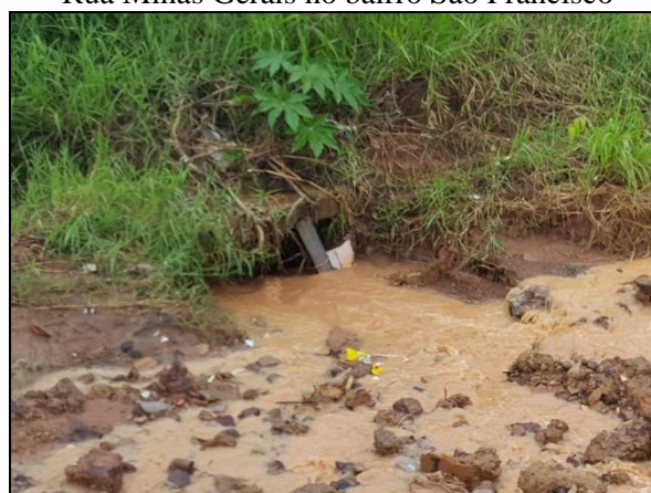
Figura 11. Boca de lobo coberta com mato e sem sarjetas para direcionamento das águas pluviais na Rua Minas Gerais no bairro São Francisco
