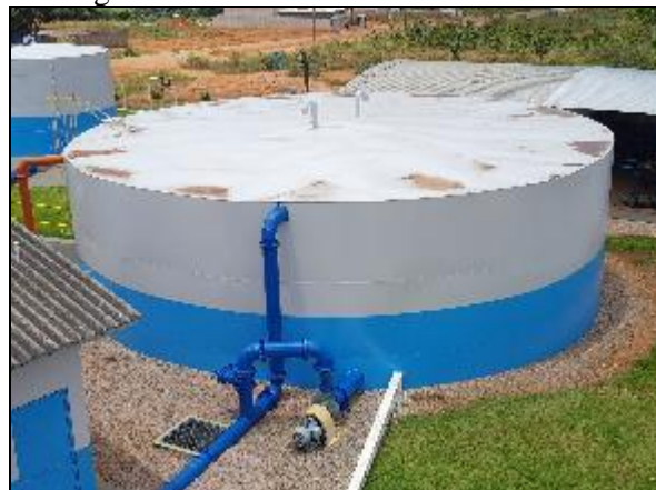
Figura 5. Reservatório RAP-02 de 600 m 3
