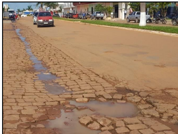
Figura 9. Águas servidas escoando na Av. Valdir Masutti, no Centro
