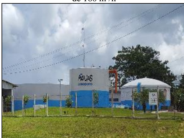
Figura 2. ETA metálica com capacidade nominal de 160 m 3 /h
