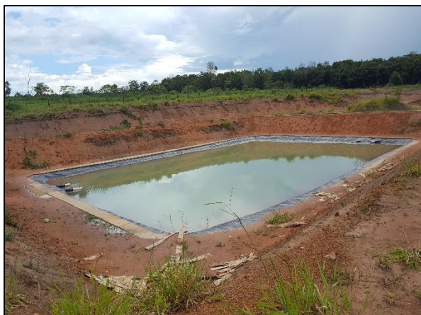
Figura 6. Lagoa anaeróbia da ETE de Comodoro
