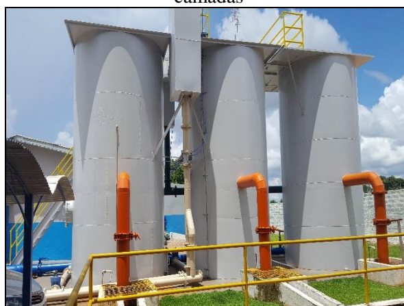
Figura 3. Filtros de fluxo descendentes com múltiplas camadas
