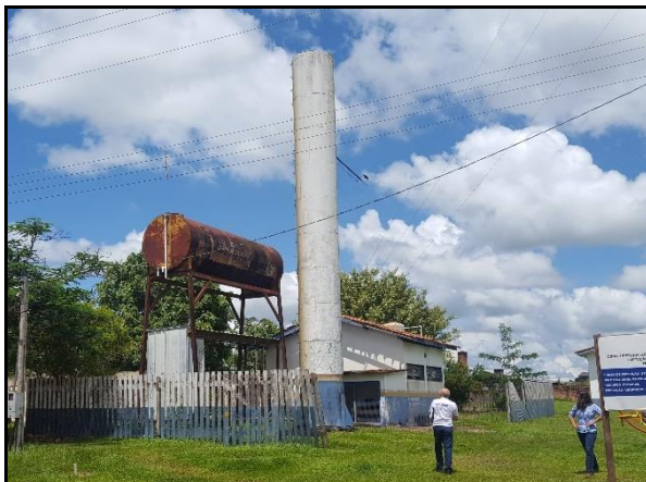
Figura 24. Reservatório de 50 m 3 utilizado para abastecimento do distrito de Nova Alvorada
