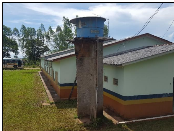
Figura 23. Reservatório elevado de PRFV na escola em Colônia dos Mineiros
