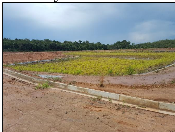
Figura 7. Lagoa de maturação e canaleta de drenagem da ETE de Comodoro
