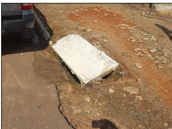
Figura 10. Boca de lobo assoreada e sarjeta danificada na Av. Pref. Valdir Masutti no Centro
