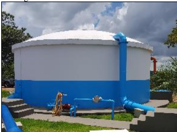
Figura 4. Reservatório RAP-01 de 200 m 3
