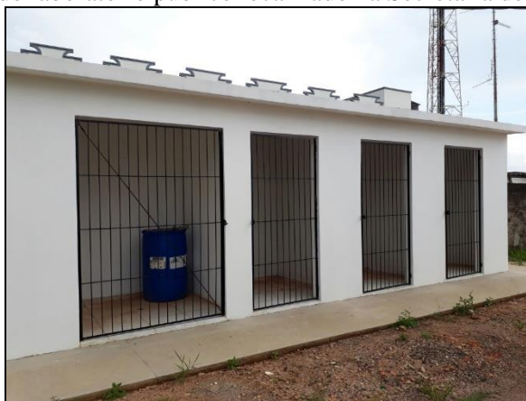
Figura 20. Abrigo externo para armazenamento temporário dos RSS do laboratório público localizado na Secretaria de Saúde
