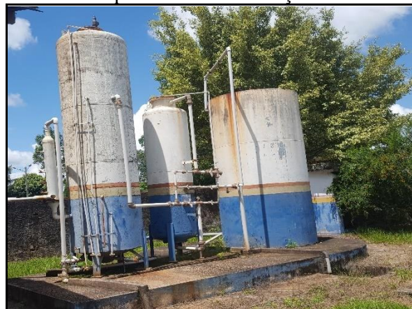
Figura 25. ETA do distrito de Nova Alvorada atualmente inoperante devido ao seu estado precário de conservação
