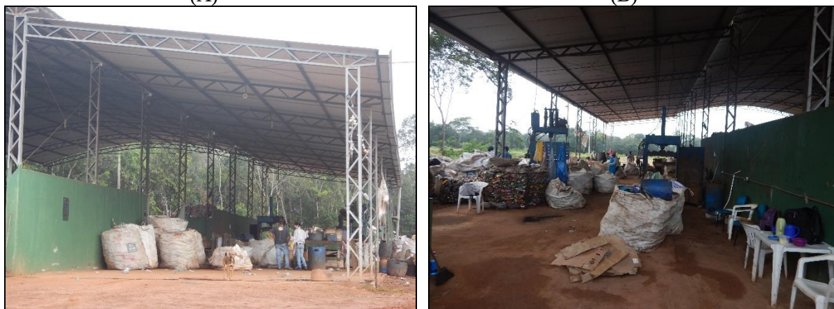
Figura 9. Galpão do centro de triagem de resíduos sólidos (A) Parte externa (B) Parte interna
