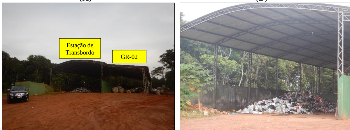
Figura 8. (A) Estação de transbordo e galpão de reciclagem (B) Disposição dos resíduos úmidos no piso da estação de transbordo (C) Rampa de carregamento dos resíduos úmidos (A) (B)
