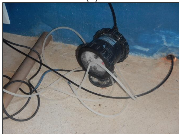
Figura 3. (A) Reservatório de diluição do hipoclorito de sódio e (B) Bomba dosadora
