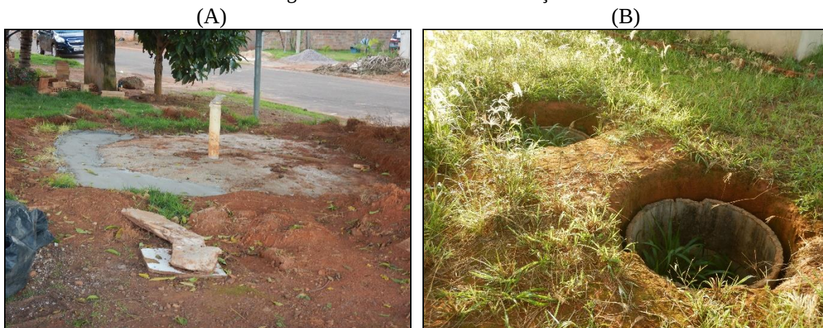
Figura 5. Sistema de tratamento individual por fossa (A) Visão de fossa construída (B) Fossa séptica seguida de sumidouro em construção
