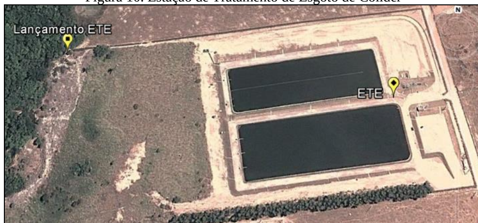
Figura 10. Estação de Tratamento de Esgoto de Colíder
