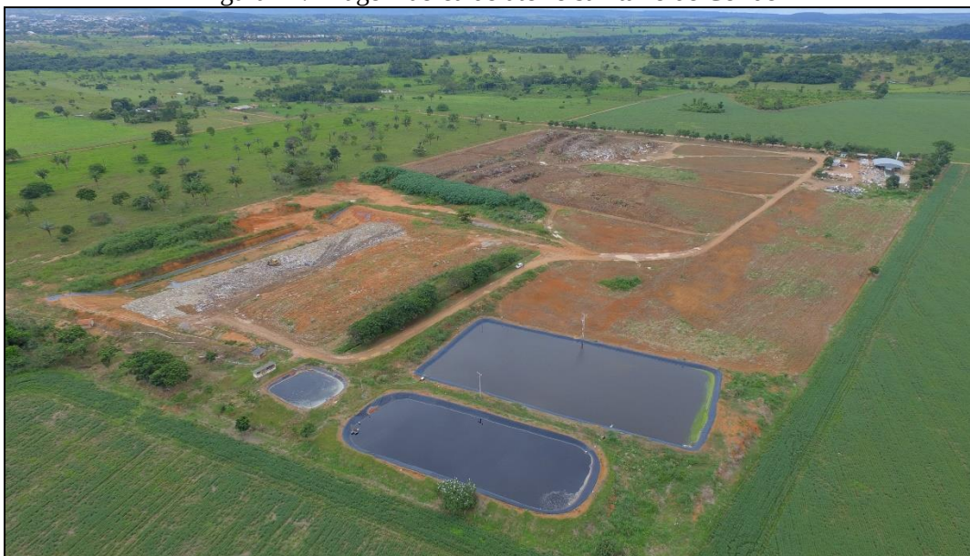
Figura 14. Imagem aérea do aterro sanitário de Colíder
