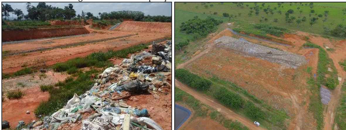
Figura 15. Valas de deposição dos resíduos sólidos do aterro
