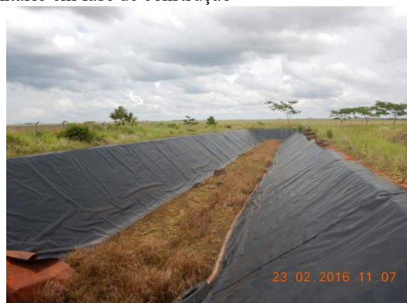
Figura 12. Área do aterro sanitário em fase de construção
