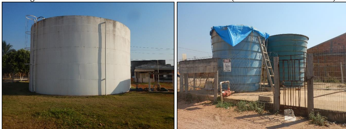
Figura 3. Reservatório RAP 01 e reservatórios RAP 02 e 03 (semelhante aos RAP 04 e 05)
