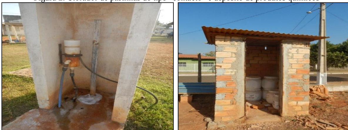
Figura 2. Clorador de pastilhas do tipo “contacto” e depósito de produtos químicos
