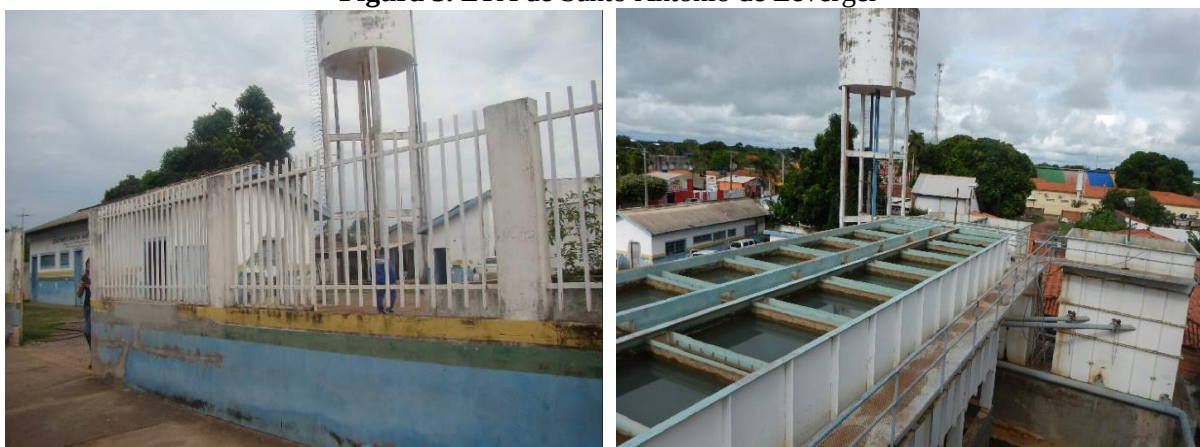
Figura 3. ETA de Santo Antônio de Leverger
