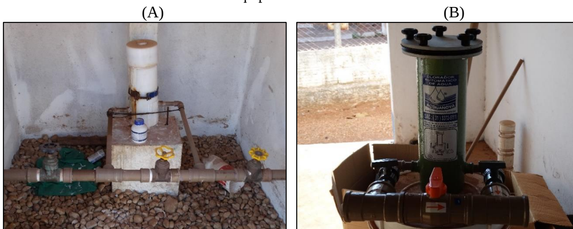
Figura 4. Clorador de pastilhas utilizados no (A) PT-02 (B) PT-03 adquirido para substituir o equipamento danificado
